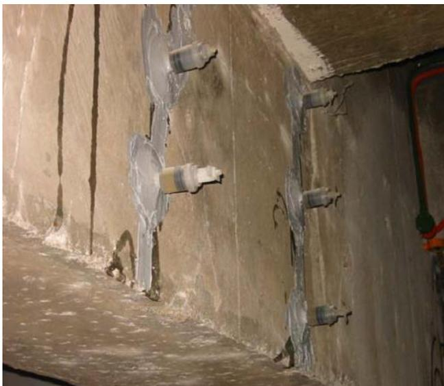
Tam Mighty Injector представляет собой небольшой резервуар с пружинным поршнем, заполняемый через смазочный ниппель.
