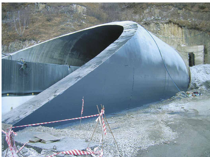
Гидроизоляция бетонных порталов тоннеля (Россия)
