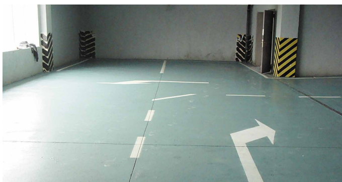
Абразивостойкое покрытие парковки (Казахстан)
