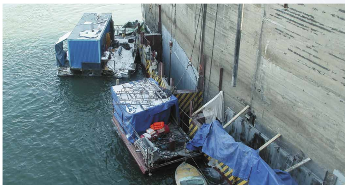
Гидроизоляция бетона в зоне переменного уровня воды на гидроэлектростанции (Россия)
