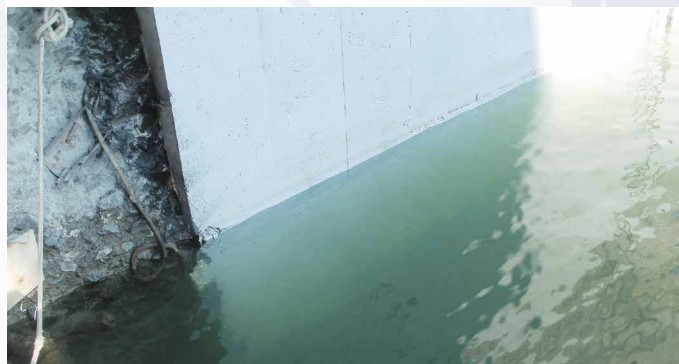
Гидроизоляция бетона в зоне переменного уровня воды на гидроэлектростанции (Россия)
