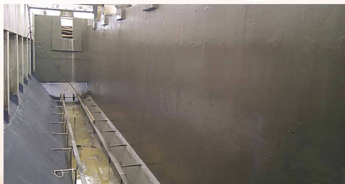
Очистные сооружения города Адлера (Россия)
