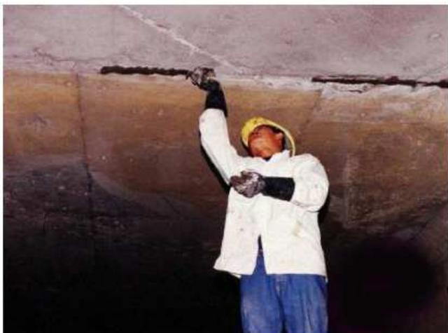
TamCrete Plug – это быстротвердеющий цементный состав, предназначенный для остановки локальных водопроявлений и зачеканки различных видов швов.
