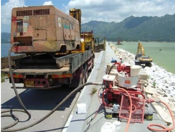
TamCrete CGB – раствор с компенсированной усадкой, объединяющий добавки для водопонижения и расширяющиеся вещества. Он разработан специально для улучшения текучести, стабильности и тиксотропных свойств раствора. Это способствует отличному закачиванию и высокой прочности при соотношении вода/цемент 0.23. TamCrete CGB подвергается технологии «двойного расширения» в процессе гидратации, что ликвидирует сжатие, обеспечивая надёжное закрытие болтов и кабельных анкеров.
