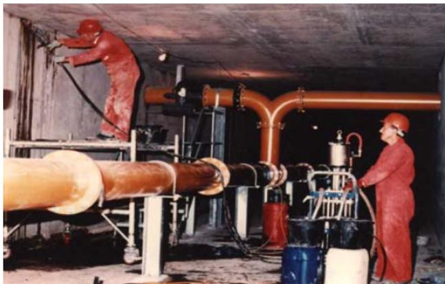
TamAcryl 3000 представляет акрилатный тампонажный состав повышенной прочности, получаемый при смешивании акриловых полимеров с упрочняющим водным раствором латекса, катализатором реакции и ускорителя. После смешивания данных компонентов, в процессе реакции, образуется водонепроницаемый гель.
