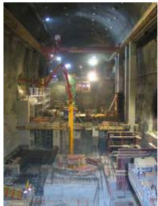
Powerhouse Cavern Kopswerk II, Partenen, Austria
