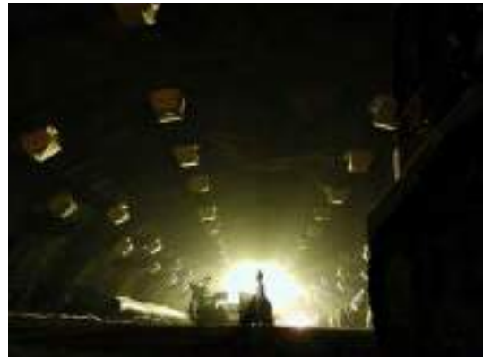
Powerhouse Cavern Kopswerk II, Partenen, Austria
